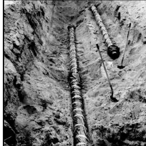
Рисунок 6.24 Картриджный метод укладки труб.
