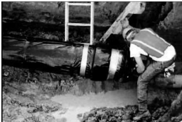
Рисунок 6.22 Покрытие труб полиэтиленовым рукавом.
